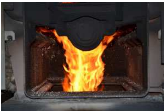
Abb. Nr. 13 Optimale Flammenform
