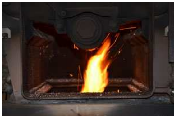
Abb. Nr. 14 Nicht geeignete Flammenform
